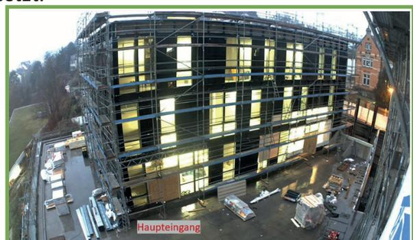
Bei eingeschalteter Baubeleuchtung lässt sich die bauerwerkintegrierte Photovoltaik an der Fassade besser erkennen (= dunkle Bereiche).
