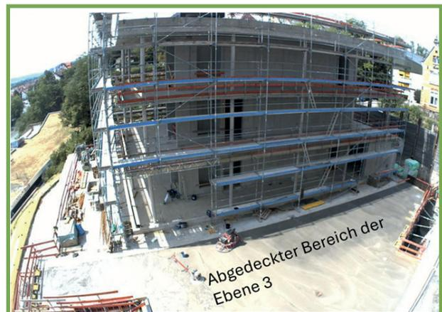
Hinter dem Gerüst wurde die Fassade montiert:
