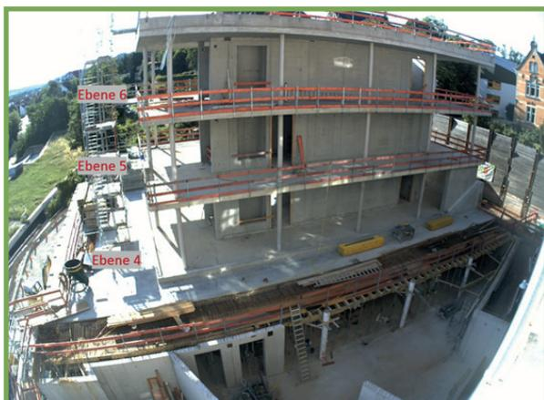
Anschließend wurde der noch oben offene Bereich der Ebene 3 abgedeckt und die Ebenen 4-6 wurden eingerüstet:
